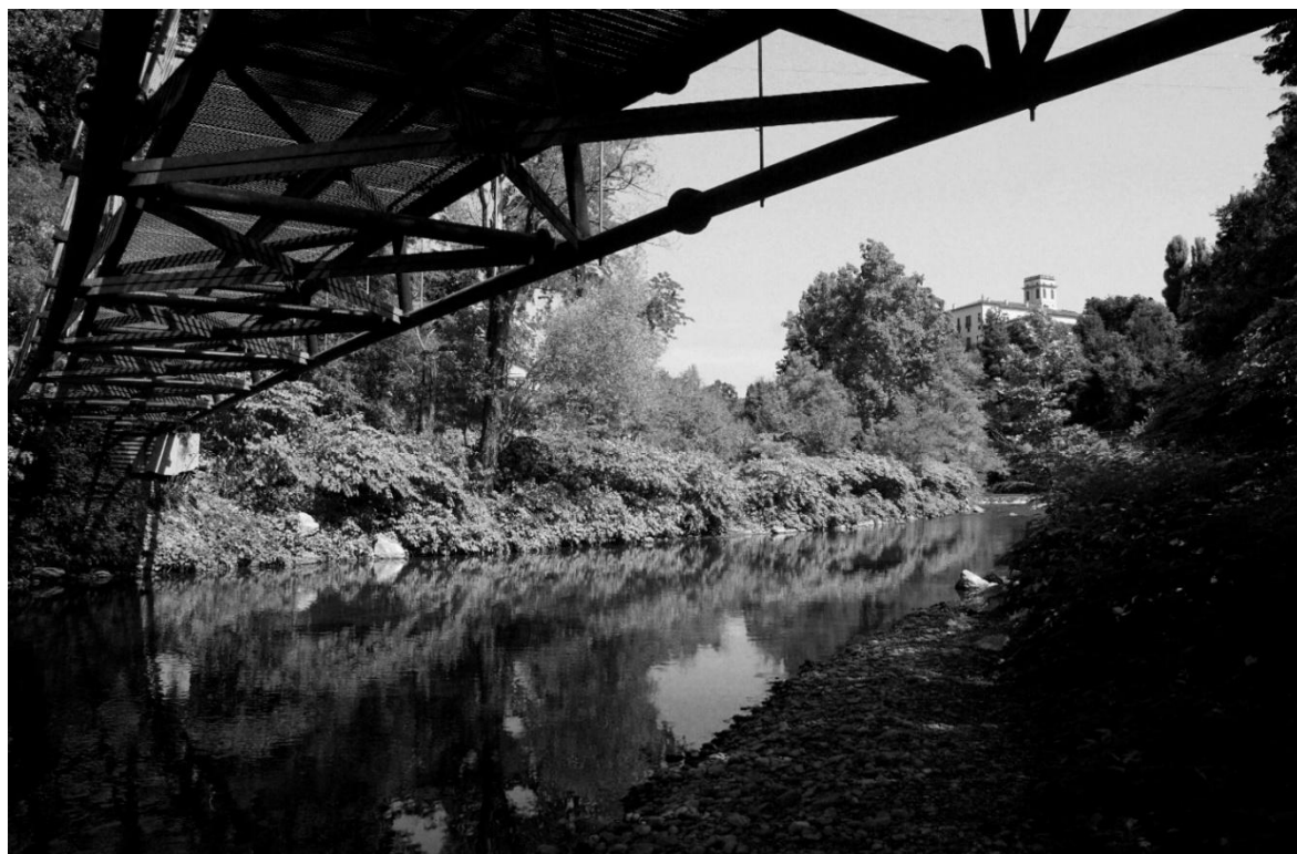
Gerno, Località Gernetto: ponte di ferro sul Lambro, agosto 2024
